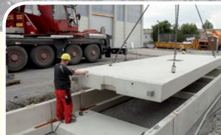
Platzsparende Montage – dank modularer Konstruktion und leichter Bauteile
